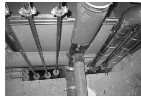
Installationsstrang Heizung-Wasser-Lüftung
